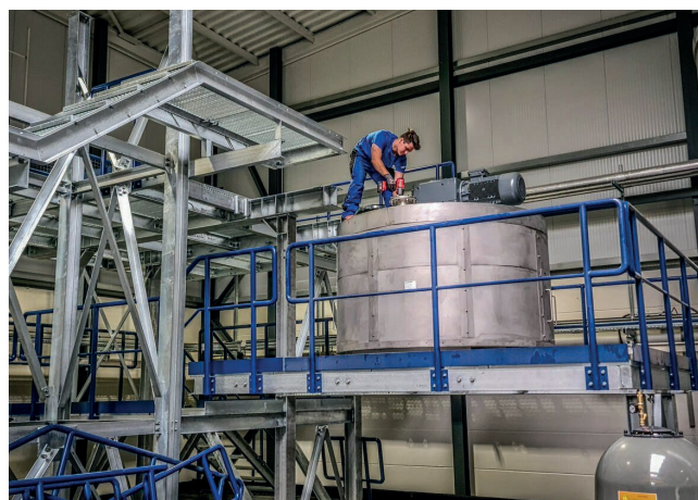
Bild 6. Das Hot-Wash-System von Lindner kombiniert Heißwäsche und Trocknung der Kunststoff-Flakes
